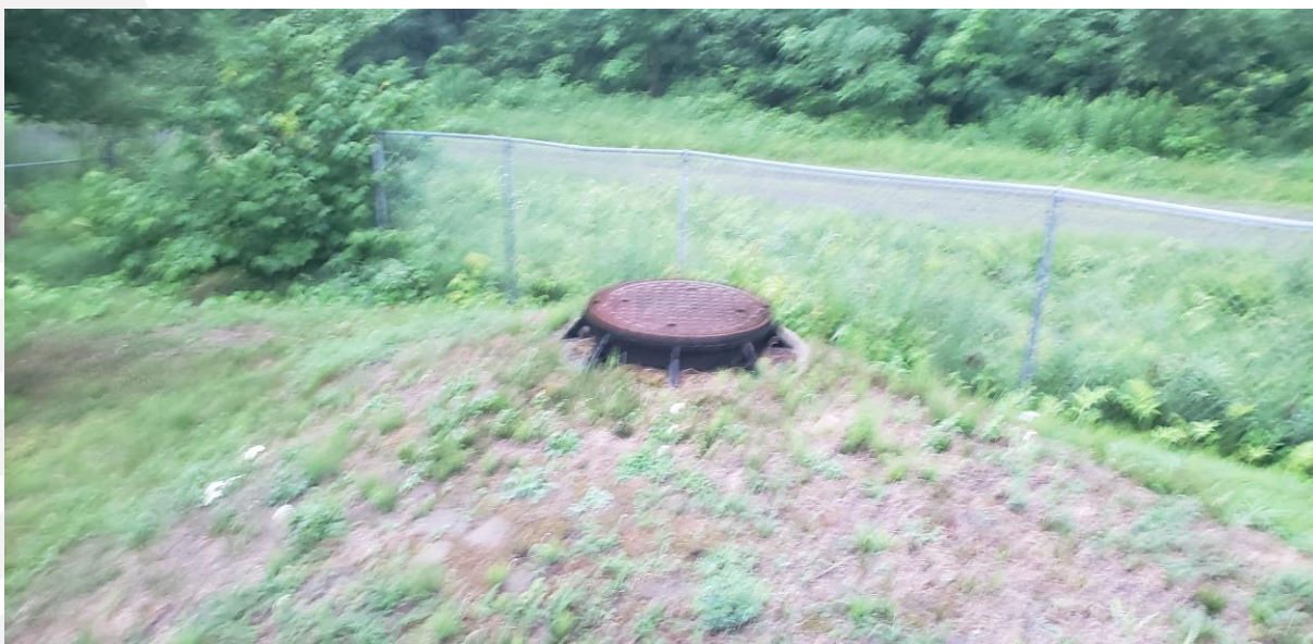
Vue du regard d'évacuation du trop-plein du puits P-3 (puits artésien jaillissant)
